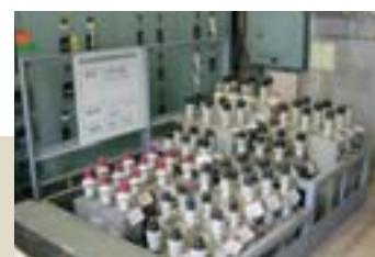
PCBの保管状況
