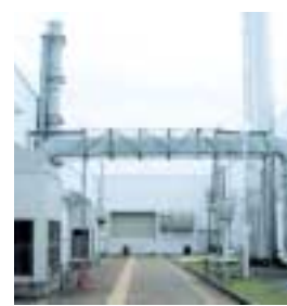
機械室排熱活用ダクト
