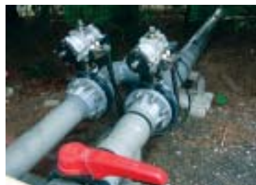
緊急時用配管
