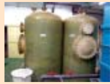
廃液濾過装置
