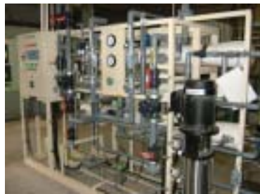
超純水・RO濃縮水回収装置
