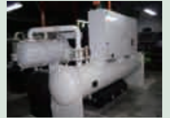
新規に導入した冷凍機
