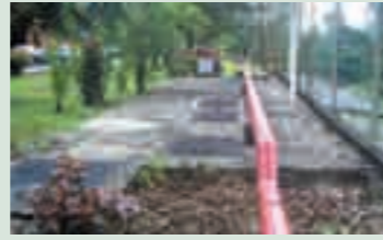
処理タンクの上部
