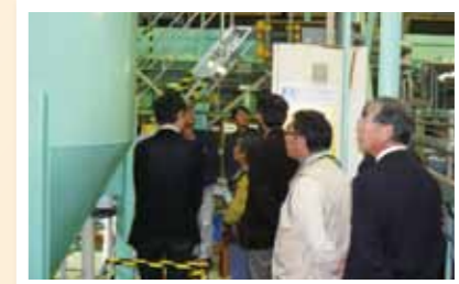
参观废弃液体处理设施
